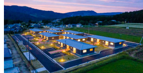
下西原第2団地(木造長屋 8棟16戸)
