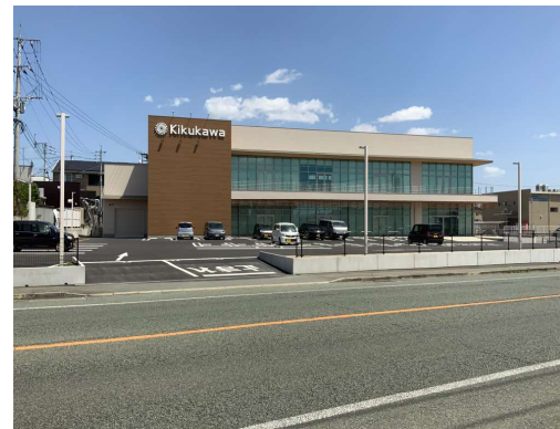
■KIKUKAWA 2020年竣工 規模:鉄骨造2F建て 1990㎡ 建築地:熊本県熊本市北区 地震により被災した店舗の建て替え工事 売り場のレイアウトを邪魔しないような箱型のプランで構成し、売り場に面する柱径を細くする事でフレキシブルな空間となっている。
