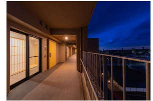
市ノ後第2団地(RC造5階建て 40戸)
