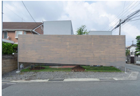
■CLT塀の家 2020年竣工 規模:木造2F建て 211.47㎡ 建築地:熊本県熊本市中央区 密集した住宅地に建つ建物。浮遊したCLTの塀により近隣に圧迫感を与えないようにプライベートな庭を作った。
