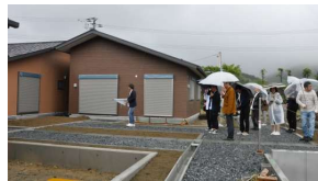
石巻市北上にっこり団地 建設現場視察
