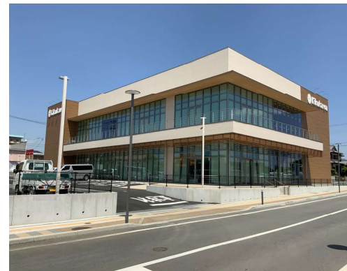
■KIKUKAWA 2020年竣工 規模:鉄骨造2F建て 1990㎡ 建築地:熊本県熊本市北区 地震により被災した店舗の建て替え工事 売り場のレイアウトを邪魔しないような箱型のプランで構成し、売り場に面する柱径を細くする事でフレキシブルな空間となっている。
