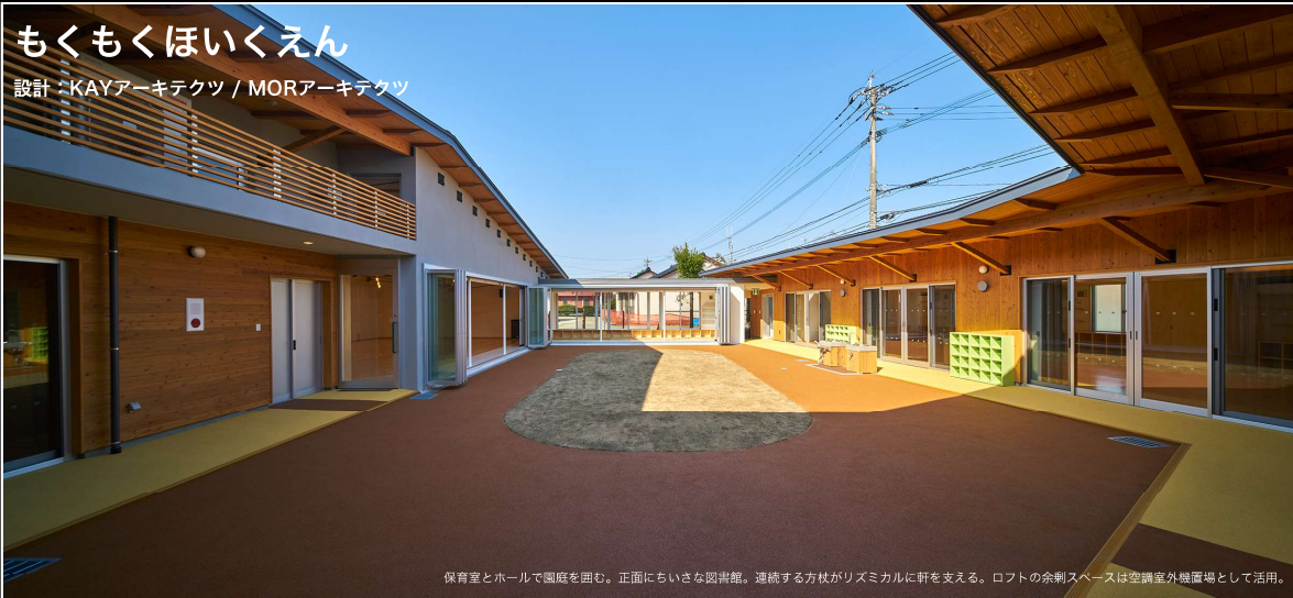
保育室とホールで園庭を囲む。正面に大きな図書館。連絡する方柱がリズムカルに軒を支える。ロフトの余剰スペースは空調室外機置場として活用。
