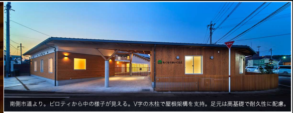
南側市道より。ピロティから中の様子が見える。V字の木柱で屋根架構を支持。足元は高基礎で耐久性に配慮。
