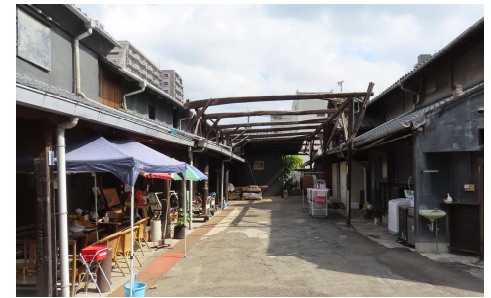
未指定文化財 早川倉庫地震被害復旧(2020)
