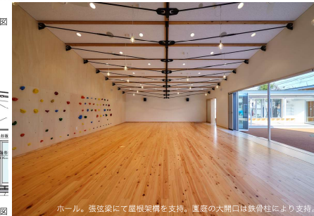
ホール。張弦梁にて屋根架構を支持。屋根の大開口は鉄骨柱により支持。
