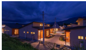
西原村買取型災害公営住宅 山西団地
