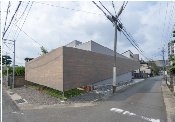
■CLT塀の家 2020年竣工 規模:木造2F建て 211.47㎡ 建築地:熊本県熊本市中央区 密集した住宅地に建つ建物。浮遊したCLTの塀により近隣に圧迫感を与えないようにプライベートな庭を作った。
