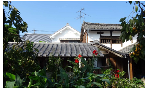
未指定文化財 若城金物店地震被害復旧(2019)
