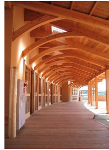
鹿央保育園 外廊下
