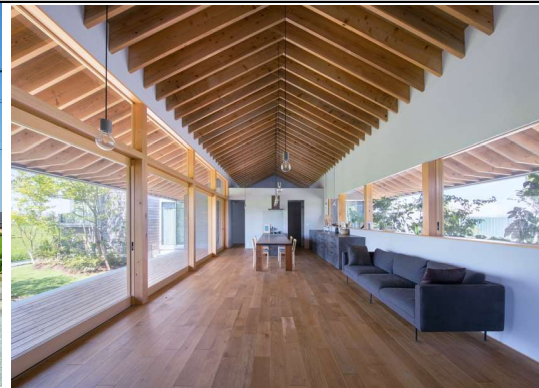
■切妻と土間の家 2019年竣工 規模:木造平屋144.08㎡ 建築地:熊本県熊本市南区 田園風景広がる敷地に建つ建物。作業空間兼ギャラリーである土間を持ち、切り妻の架構は木の線材を多用して木の量感ある空間となっている。
