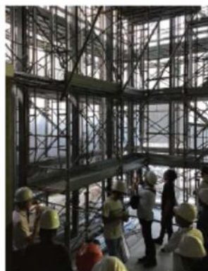
カーテンウォール施工中の1Fホール
