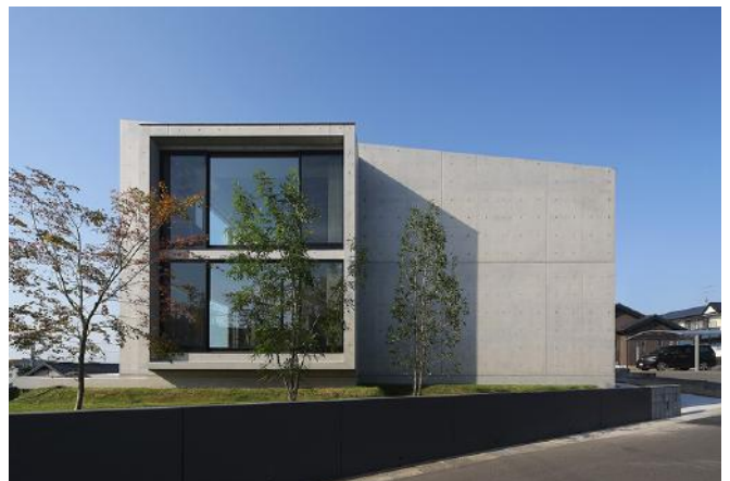
シラスコンクリート住宅
