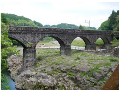
明正井路第一拱石橋（明正井路一号幹線一号橋）
