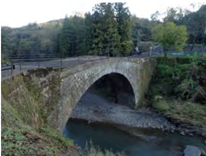
虹潤橋（柳井瀬橋）
