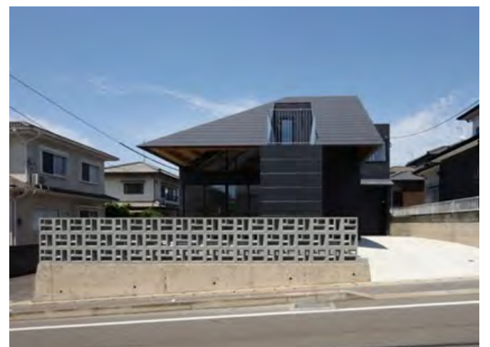
「大屋根の家」2021年5月竣工
