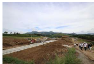
震災ミュージアム工事現場視察
