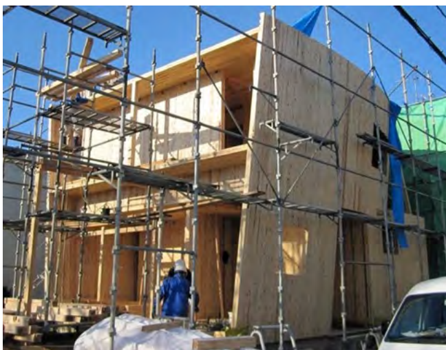
杉105角を用いた木造積層工法 (広島)
