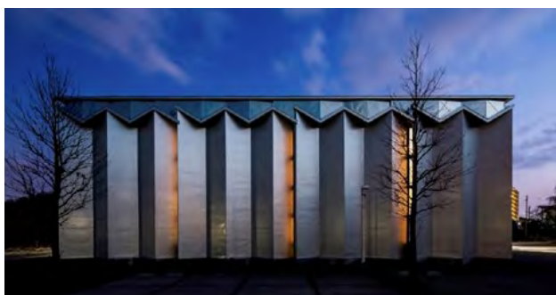
外壁は断熱材+耐久性の高いガルバリウム鋼板 写真:大森今日子
