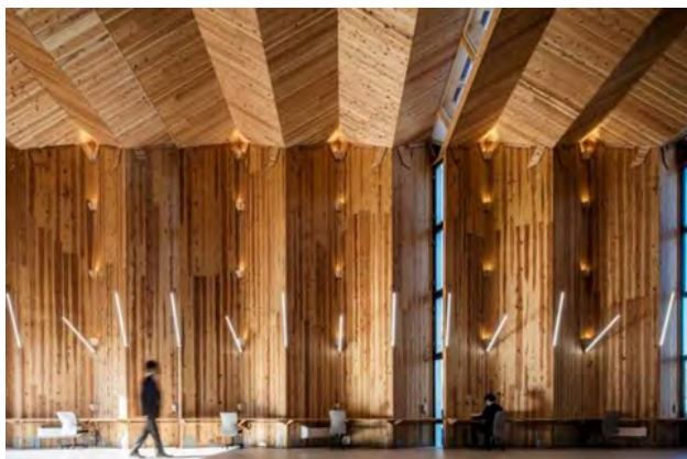
天井高7.5mの空間をCLTを屏風状に配置し実現 写真:大森今日子
