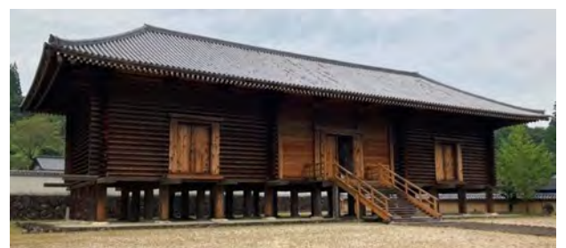
宮崎県に建設された西の正倉院
