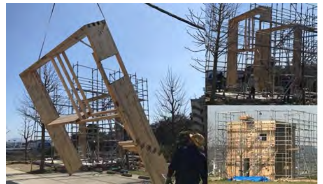
ロボットによる住宅建設のため実験風景
