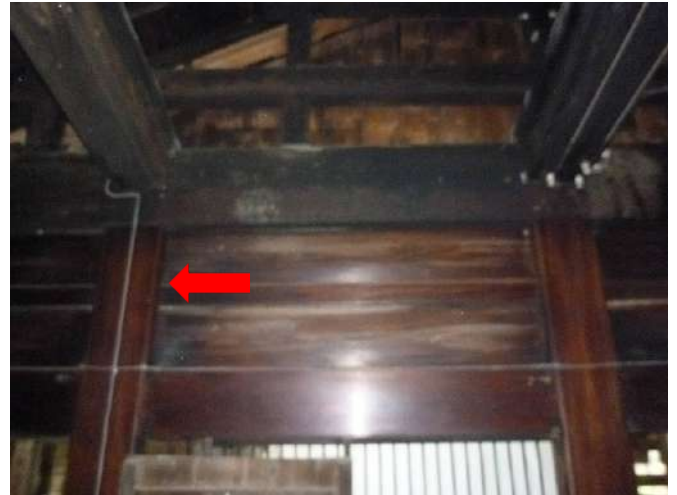
■（上島）佐護地区の古民家の内部
