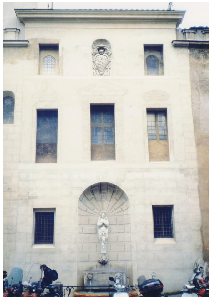
建築にだまし絵(像の背面の壁もだまし絵。実際の開口部は3ヶ所)
